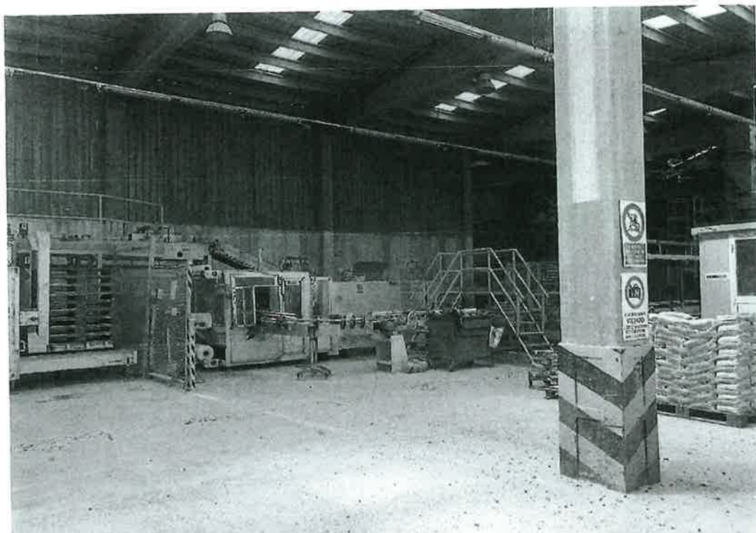
Sito di Santa Brà – stato insacchettatrice al 17.07.2024 (ferma) in affitto a "SARDECO" e di proprietà POLAR
